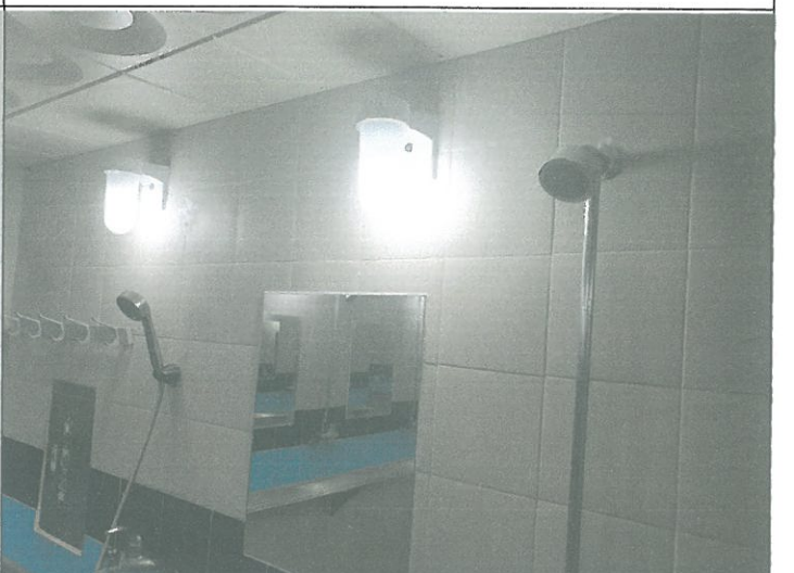
수영장 남자 샤워장 내 벽 등 1개소 전구 교체
