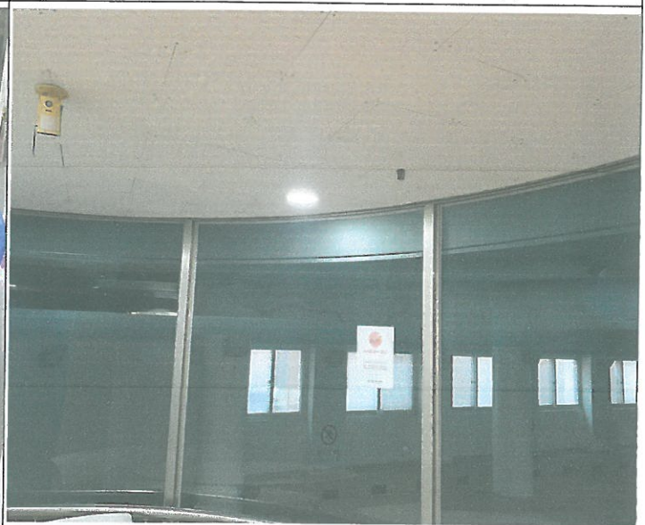
지하1층 수영장 로비 천장 다운라이트 1개소 교체
