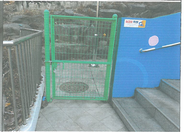
수영장 외부 철재문 시건장치 불량 수리
