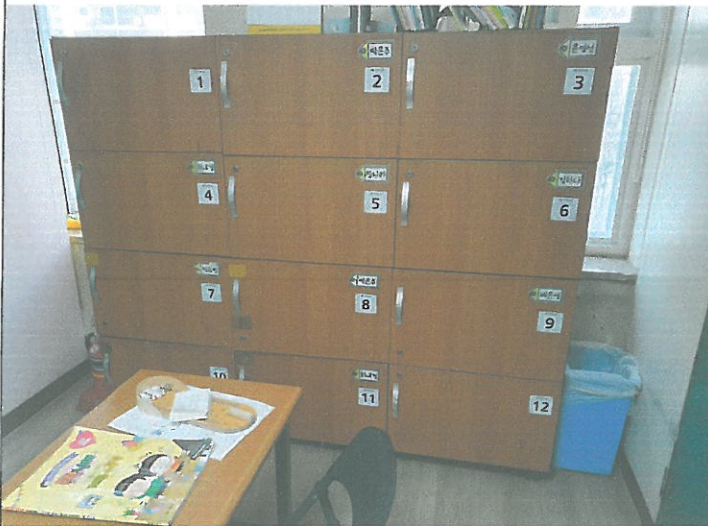
3층 피아노실 교부제 수납장 2개소 문짝 유격 조정 보수
