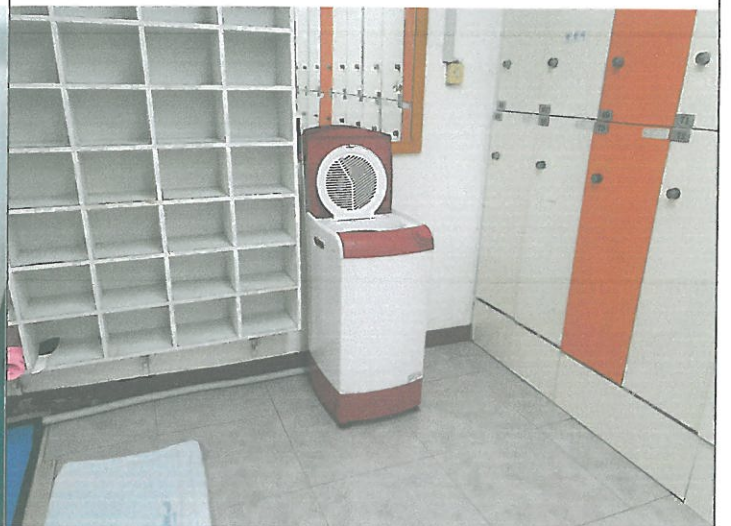
수영장 남. 여. 탈의실 탈수기 수평조정 바닥고정
