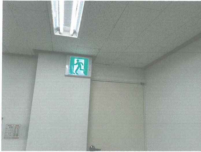
청소년극장 준비실 천장 텍스 파손개소 보수
