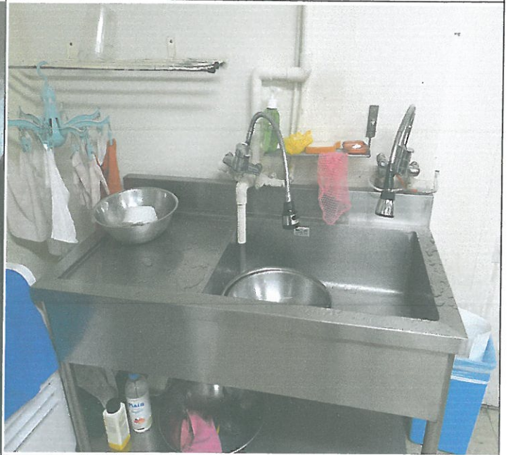
지하 1층 제과 제빵실 싱크대 수도가량 노즐 조정 및 배수구 수정 설치
