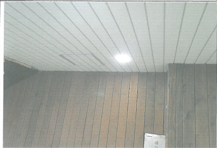
지하1층 수영장 출입구 천장 다운라이트 1개소 교체
