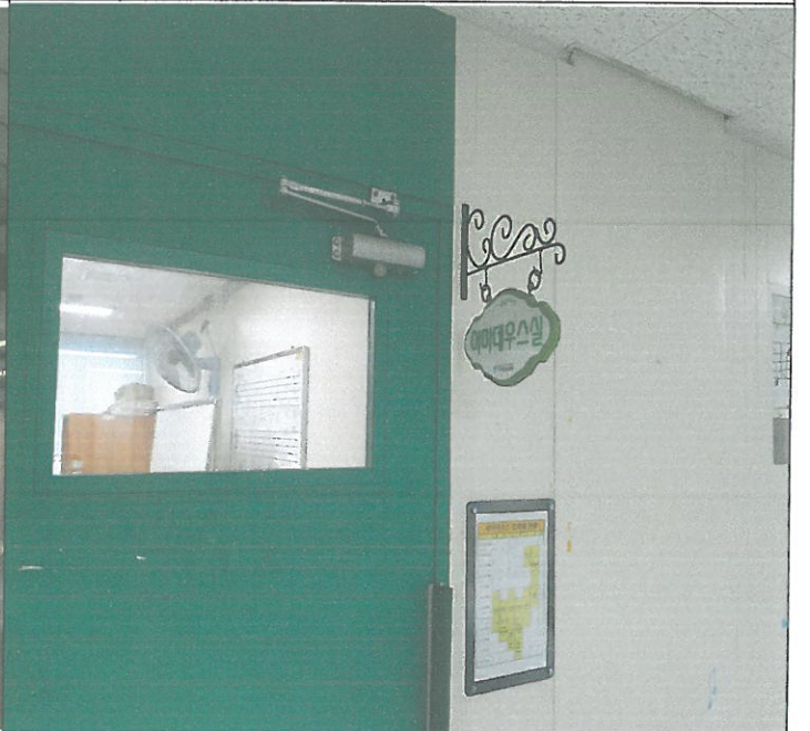
3층 아마데우스 출입문 도어크로저 탈락 수리
