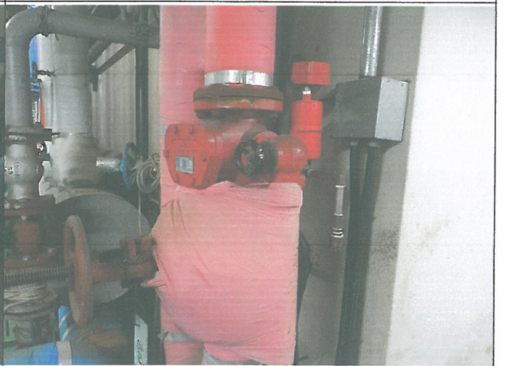
지하 2층 알람 밸브 이상감지 작동 밸브 해체 내부세관 후 조립
