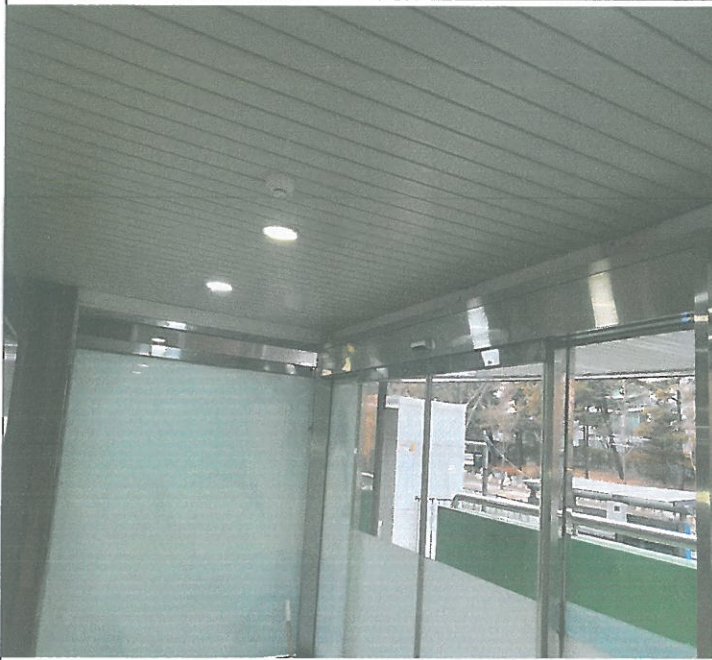
수영장 출입구 방풍실 천장 다운라이트 2개소 교체
