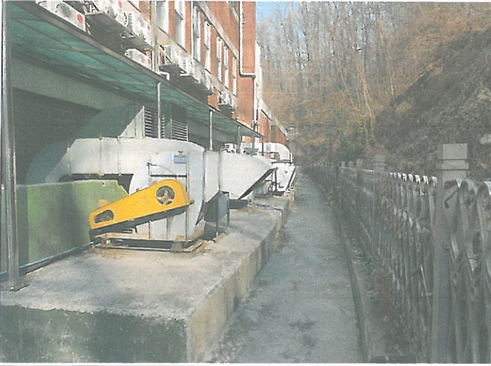
건물후면 각종 배기팬 점검 구리스 주입
