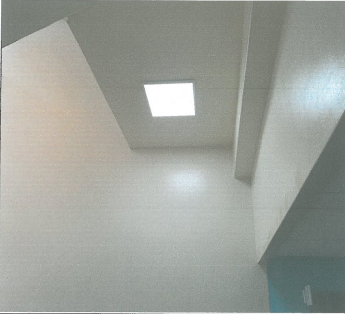
1층 로비 천장 사각 매립 등 1개소 교체
