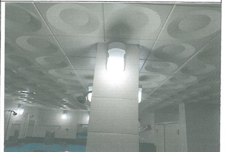
수영장 남자 샤워장 내 벽등 전구 1개소 교체
